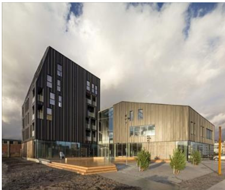
Materialerne i det Nordatlantiske Hus, der åbner i morgen i Odense, understøtter bygningens rene og enkle formsprog, der er karakteristisk for arkitekturen i Grønland, Island og Færøerne. (Foto: Adam Mørk)
